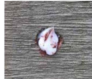
KÖSTER Crisin Creme ma stabilną konsystencję. Dlatego nawet jeżeli do otworu podana zostanie zbyt duża ilość materiału krem iniekcyjny nie spływa po ścianie i nie powstają ciemniejsze ślady zacieków na tynku. Nadmiar materiału należy usunąć szpachelką a otwór bez zwłoki zamknąć zaprawą KB FIX 5.
